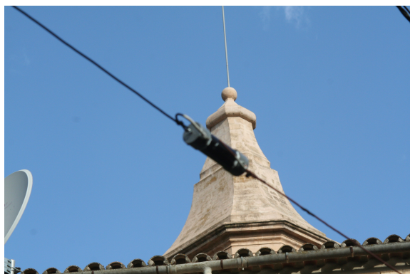
Bobina de la antena vista sobre el campanario de la parroquia
