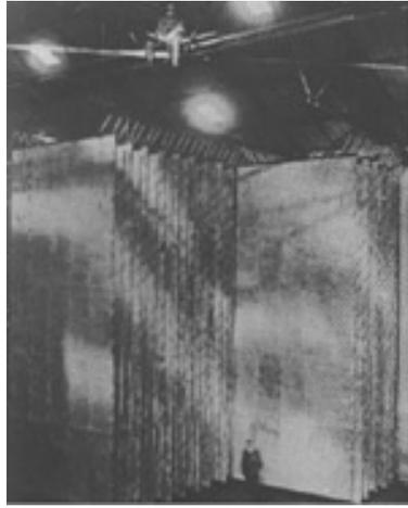
**Fig. 76.-** El condensador de Clifden durante su construcción. El hombre de pie al fondo da una idea de su tamaño.
