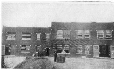
**Fig. 86.**- Edificio del transmisor. Se pueden ver las 32 bajadas de los hilos de la antena.
