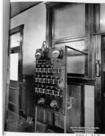
**Fig. 106.-** Cuadro de control del estado de las baterías.
