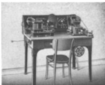
**Fig. 112.**- Mesa de recepción con el detector electrolítico.
