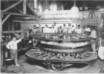
**Fig. 262.**- Construcción de una bobina del transmisor de arco. La persona de la izquierda es el supervisor, Sr. Lazarus Potognak.
