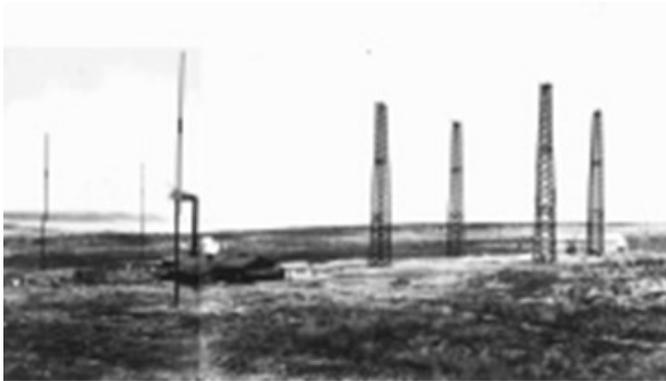
**Fig. 41.-** Fotografía de la antena hacia 1909. Se aprecian varios postes que prolongan los hilos del sombrero capacitivo en dirección a Clifden. Marconi se había dado cuenta que esta disposición presentaba efectos direccionales, no muy acusados pero que ayudaban a mantener el contacto.
