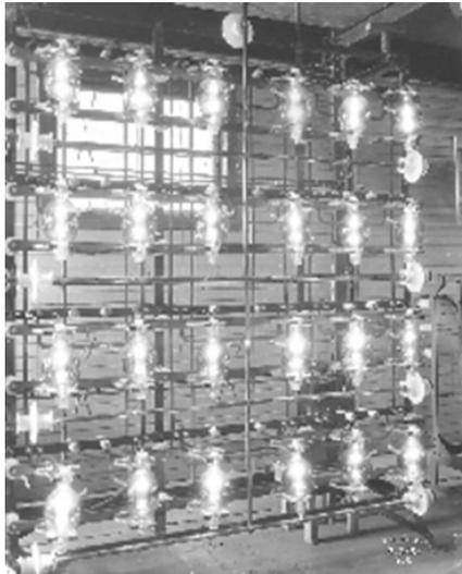
**Fig. 62.-** Primer transmisor de válvulas en Marconi Towers instalado en 1920.
