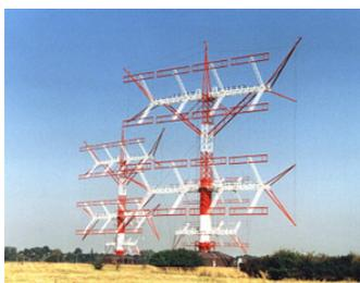
**Fig. 180.-** Antenas de cortina que emplea actualmente Telekom. El transmisor se encuentra directamente bajo la antena.
