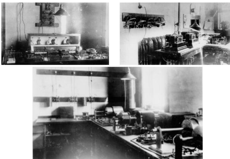
**Fig. 58.-** Diversas instantáneas de la sala de recepción en 1913. Se pueden observar los transformadores de acoplamiento, los detectores de cristal, los amplificadores electromecánicos y dos dictáfonos.
