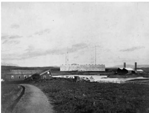
**Fig. 70.**- La estación de Clifden era de un tamaño realmente grande. A la izquierda se encuentra la residencia de los operadores, en el centro la estación y a la derecha el generador eléctrico. Se pueden ver los postes que sujetaban los hilos de la antena.
