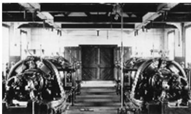
**Fig. 46.-** Generadores de 5.000 V de corriente continua conectados en serie.
