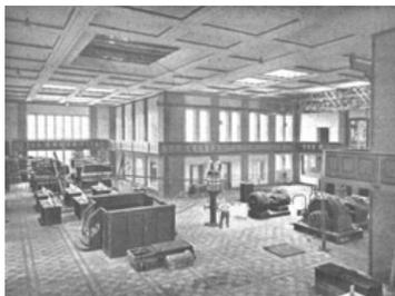
**Fig. 163.-** Sala de alternadores en construcción
