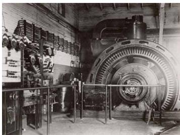
**Fig. 40a y b.**- Máquina de vapor y alternador en la estación Marconi de Table Head.
