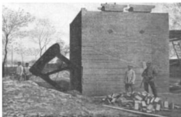
**Fig. 153.-** Construcción de un soporte de sujeción de los vientos.
