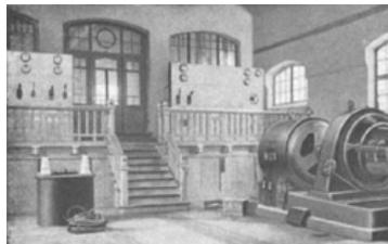
**Fig. 129.** - Sala de máquinas. A la derecha se ve el motor-generador de 100 kW.
