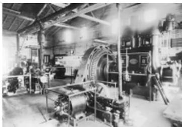
**Fig. 43.-** Máquina de vapor y alternador de la estación de Marconi Towers en 1909.
