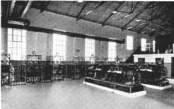
**Fig. 361.-** Paneles rectificadores de la estación de Dorchester y generadores de potencia principales.
