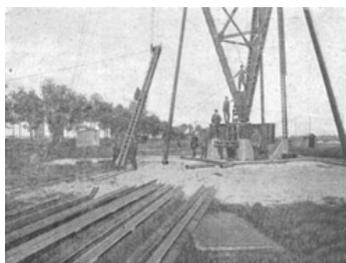
**Fig. 124.-** Construcción de la base de la torre de 260 m.
