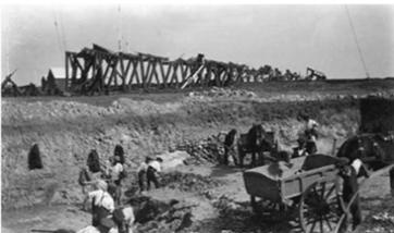
**Fig. 16.-** Desmontaje de las torres y excavación del estanque de agua.
