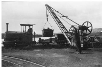
**Fig. 66.-** Para la construcción y mantenimiento de la estación de Clifden se empleó un ferrocarril ligero y se tendieron varios kilómetros de vía férrea estrecha.
