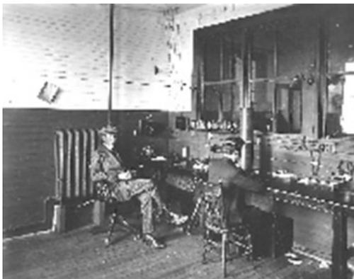
**Fig. 52.-** Otra fotografía del cuarto de recepción. El hombre sentado en la izquierda de la fotografía es Guglielmo Marconi. Sobre la mesa se aprecia el sintonizador triple, un detector magnético y en el centro lo que parece ser una bobina de sintonía (carga) de la antena.
