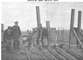
**Fig. 125.-** Derramando el protector en las sirgas.
