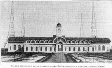
**Fig. 232.-** Edificio de la estación y las torres al fondo. La estructura central es la torre del reloj. La antena entra por el "minarete" superior.
