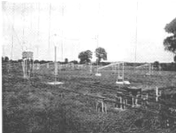
**Fig. 358.-** Alimentador de una estación Marconi. A la derecha una caja de empalmes y a la izquierda una caja de acoplamiento alimentan a los hilos de la antena.
