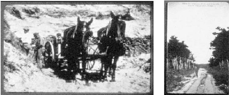
**Fig. 21a y b.**- Un momento del transporte durante la construcción. Los caminos eran duros lo que dificultaba el transporte del material pesado. A la derecha el camino de acceso conocido como “Wireless Road”.
