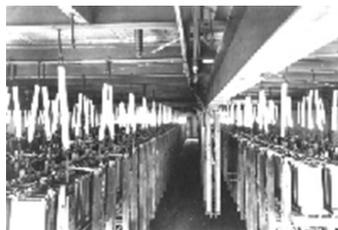
**Fig. 47.-** Batería de acumuladores en cajas cerámicas suspendidas del techo por aisladores de porcelana. Almacenaba una tensión de 12.000 voltios. En total hay 6.000 celdas.
