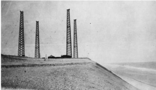
**Fig. 29.-** Aspecto de la estación en 1917. La estación estaba cerrada a causa de la I Guerra Mundial, y la erosión se acercaba peligrosamente a las dos torres Este.
